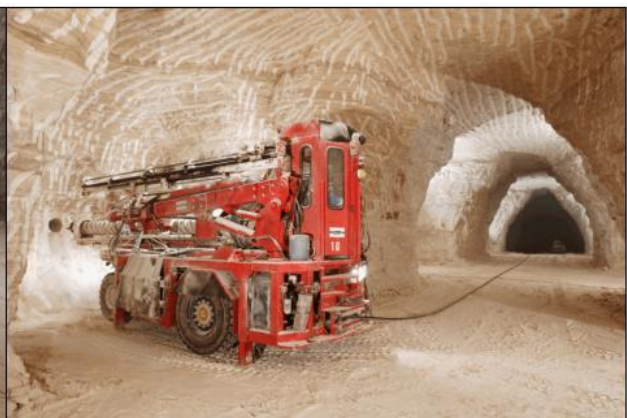
2) Foration (jumbo de foration) (au cours d'une étape de traçage - carrière de Montmorency)
