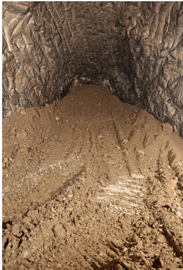
10) Remblayage total des galeries (carrière de Montmorency)
