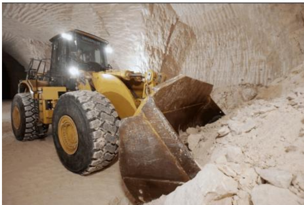
5) Chargeur sur pneus utilisé pour le marinage (reprise du tout-venant abattu), (au cours d'une étape de traçage – carrière de Vaujours)
