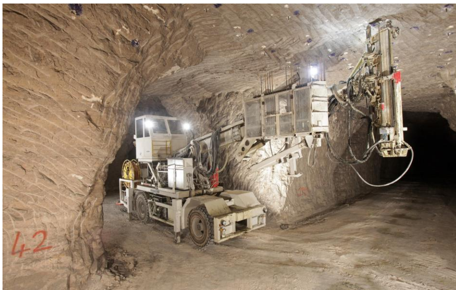
7) Boulonnage (carrière de Vaujours)
