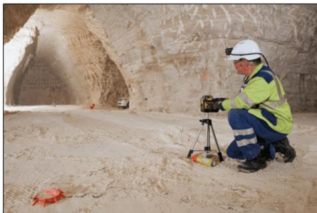
1) Alignement de l'implantation des galeries (au cours d'une étape de traçage - carrière de Montmorency)
