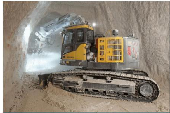
4) Pelle hydraulique équipée d'une fraise pour l'abattage mécanique (étape de traçage – carrière de Vaujours)
