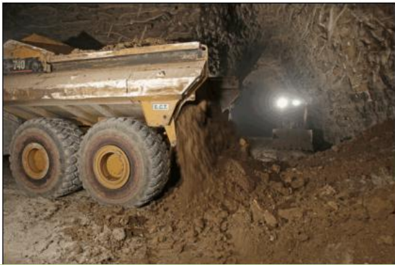
8) Dépotage des terres extérieures pour le remblayage (carrière de Montmorency)
